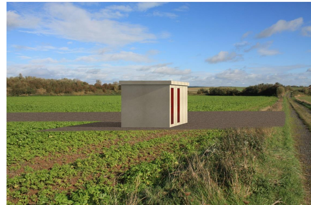
Figure 11 : Photomontage du poste de livraison envisagé pour le parc éolien de Graincourt (source : MO Architectes, 2013)
